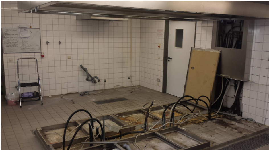
Küchenumbau von St. Johannes
