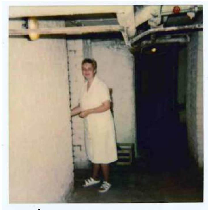
Überschwemmung Keller, St. Ulrich 1991
